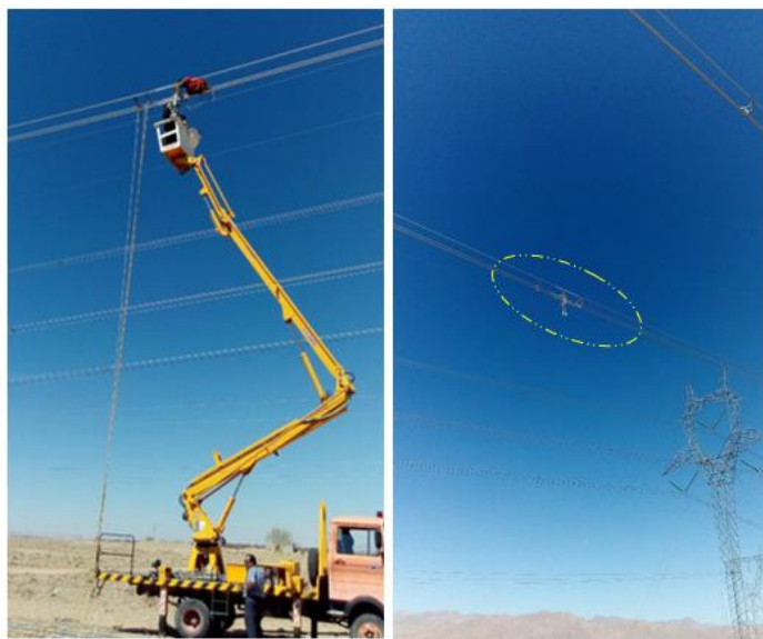
شکل ۳: نصب دستگاه هیبریدی ضدگالوپینگ
